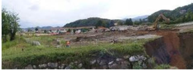
Come sia stato possibile che nessun operaio abbia subito conseguenza gravissime, come quelle già verificatesi nel lato di Malo con il decesso di un operaio, è difficile da spiegare. La volta è venuta giù portandosi dietro argine e torrente, che carico d'acqua, ha fatto il resto trasformando il danno in una voragine di 25 per 40 metri, profonda quasi 30 metri.
